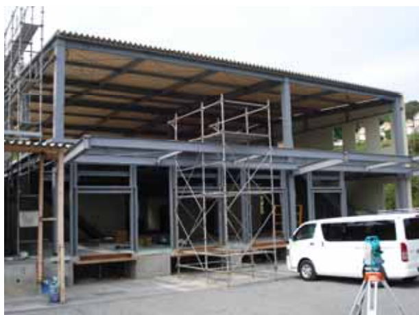
鉄骨組立：正面
