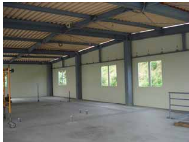
パネル組立：内部
