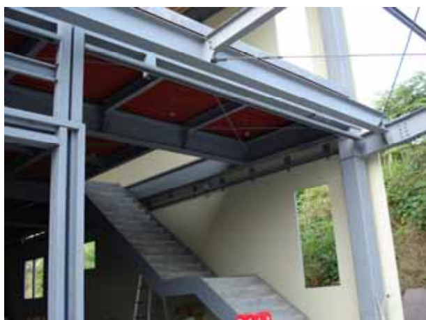
鉄骨組立：正面
