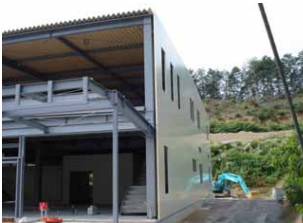
鉄骨組立：側面パネル組立
