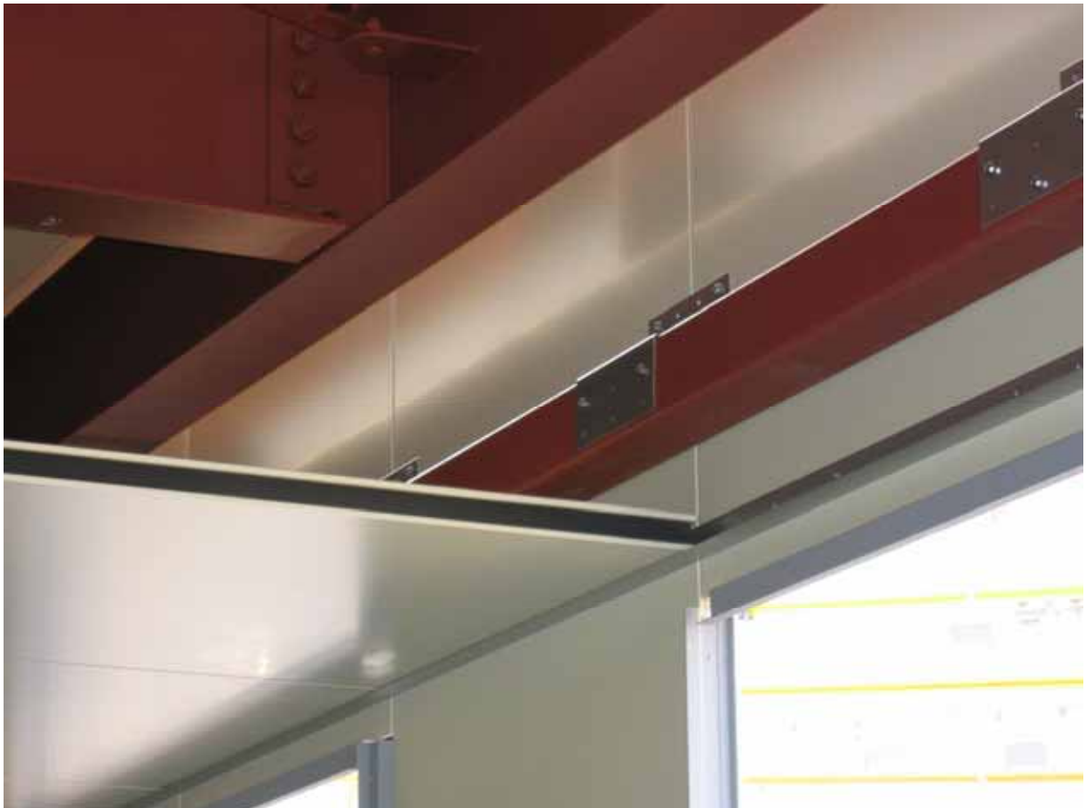
外壁パネルと胴縁固定、内部天井パネル納り
