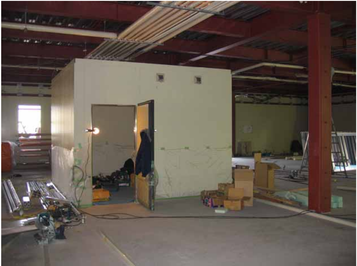
建屋内部冷凍庫 扉面
