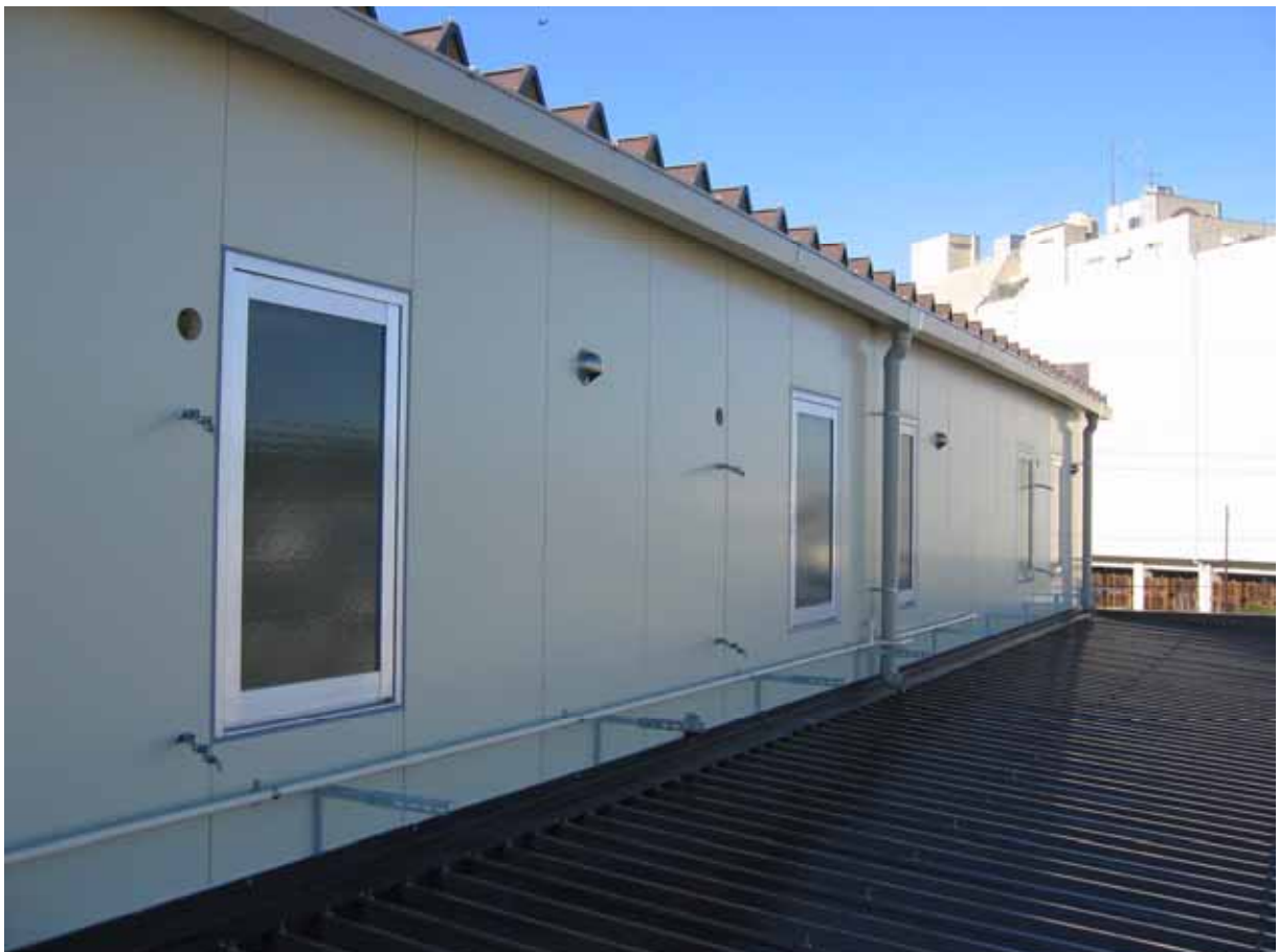
外壁パネル、サッシ窓 取り付け完了
