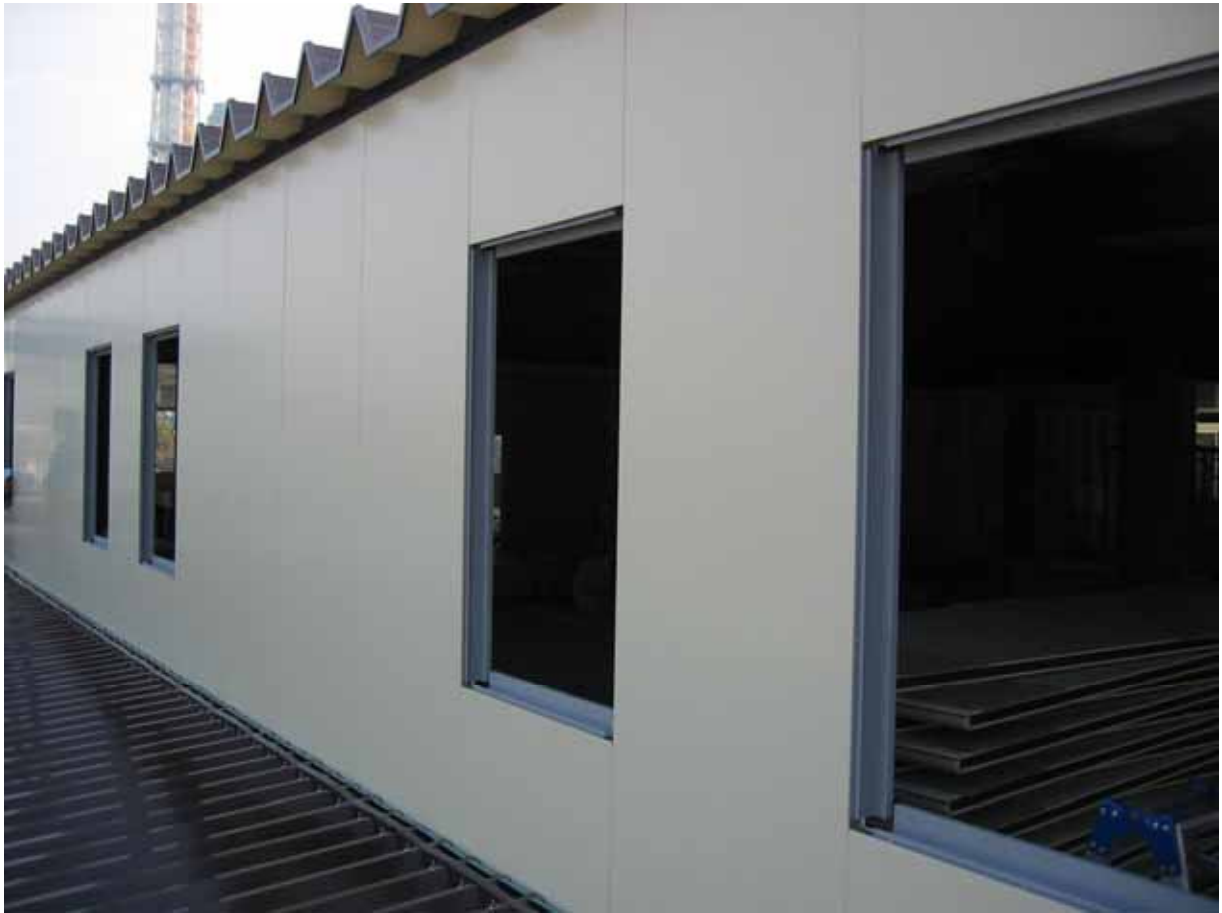
外壁パネル、サッシ窓 取付け開口枠
