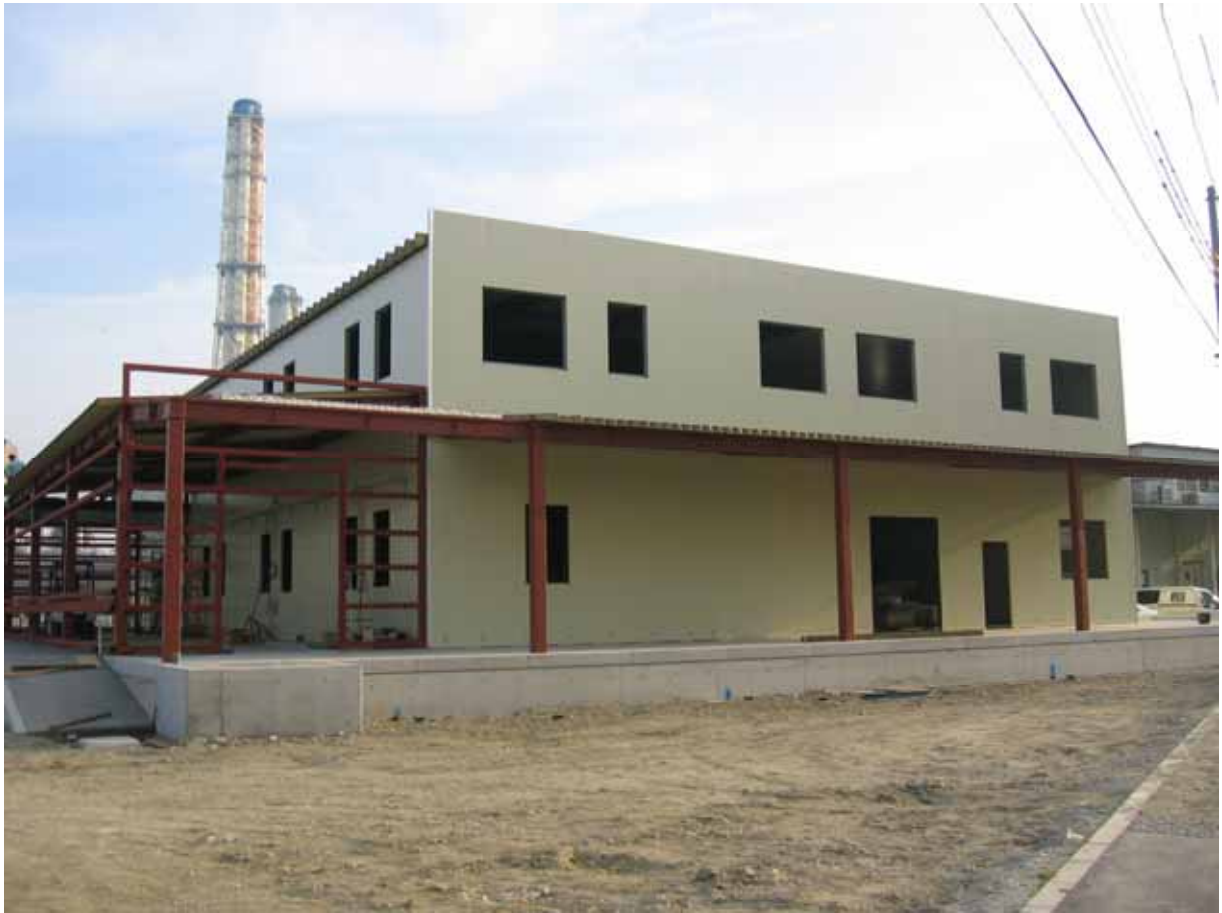
外壁パネル組立完了
