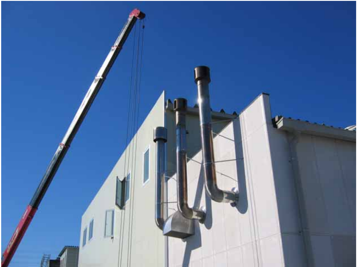
外壁パネルとボイラー室（ALC）とのジョイント
