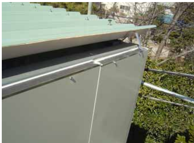
屋根ルーフデッキ
