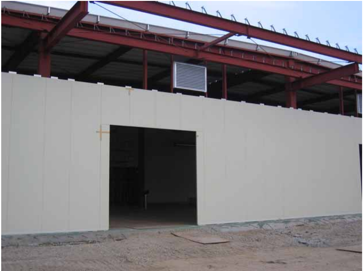
外壁パネル 組立工事
