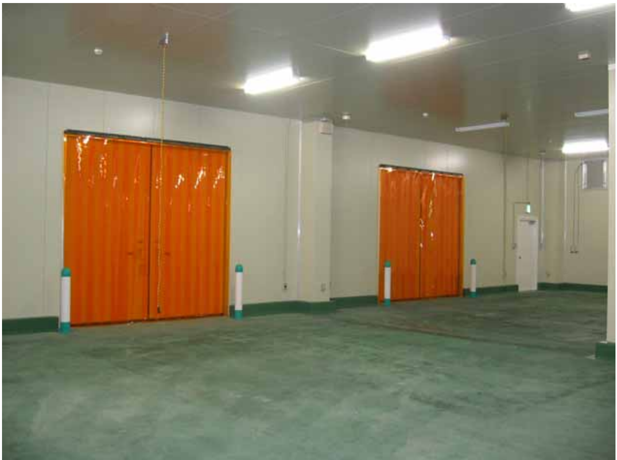
防虫色ビニールカーテン、両引き扉（室内側）
