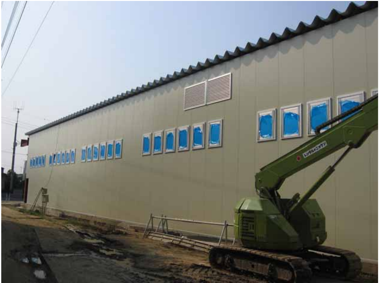
外壁パネル・排煙窓・ガラリ取付け（屋外側）
