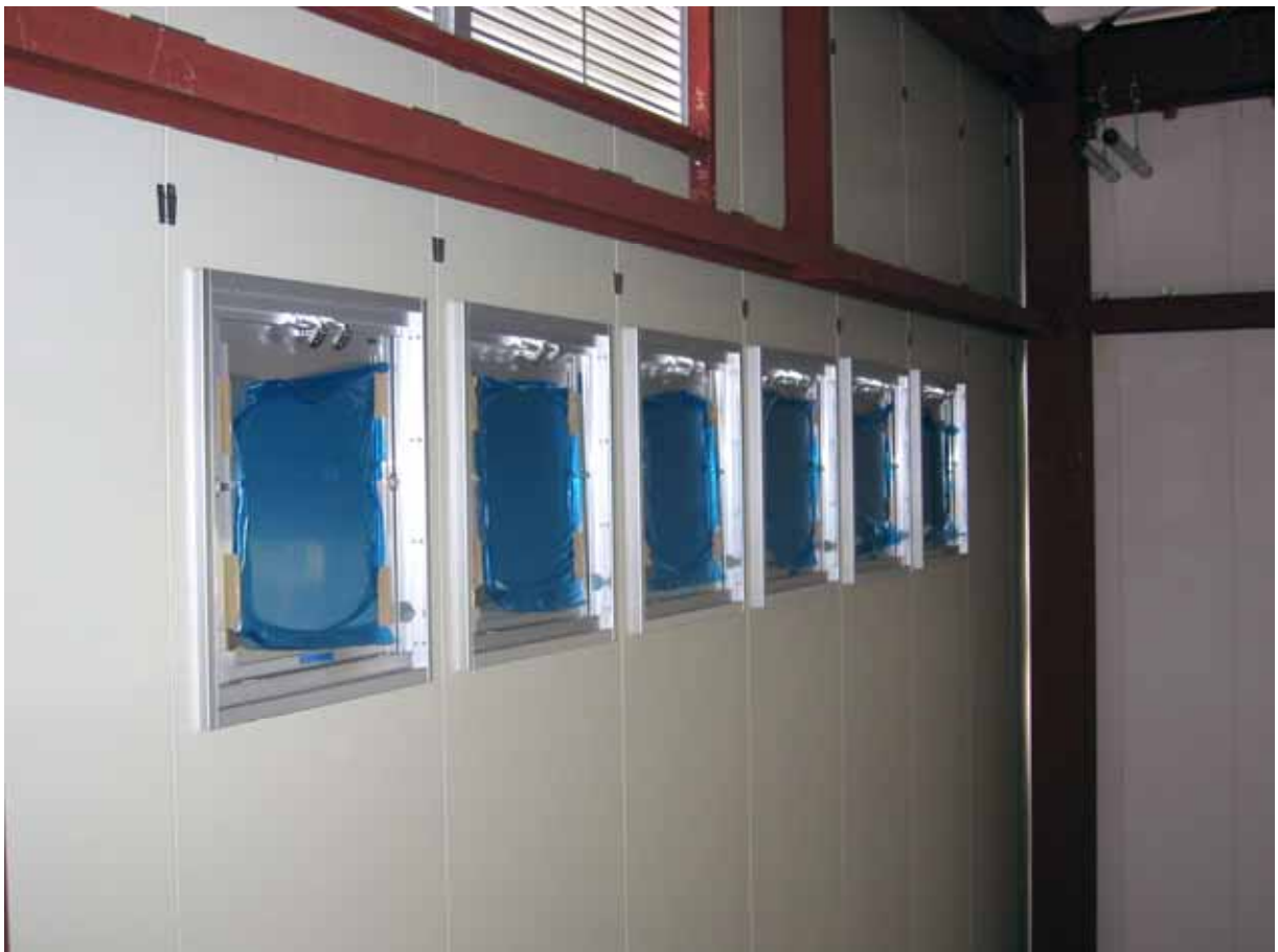
外壁パネル・排煙窓取付け（室内側）
