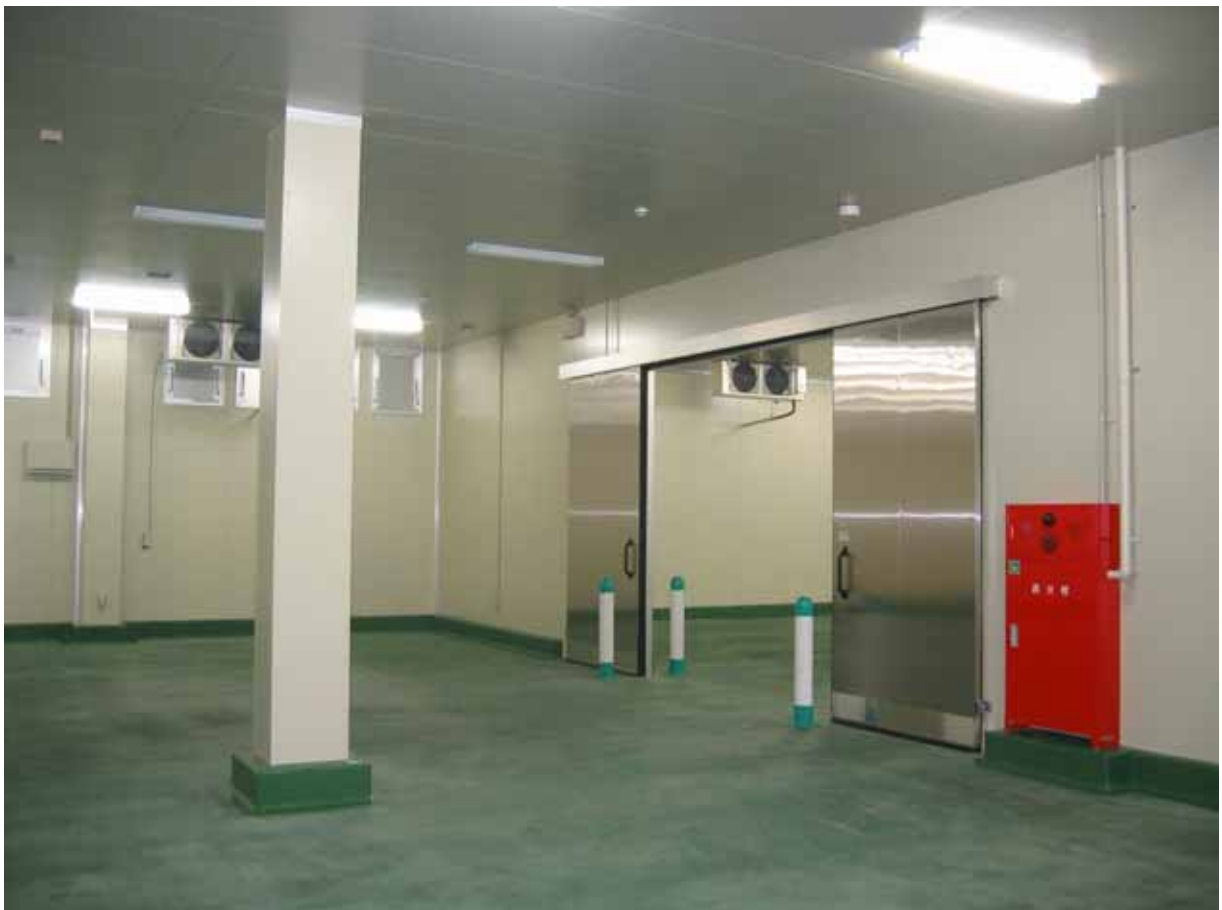
柱部仕上げ、冷蔵庫 電動両引き扉
