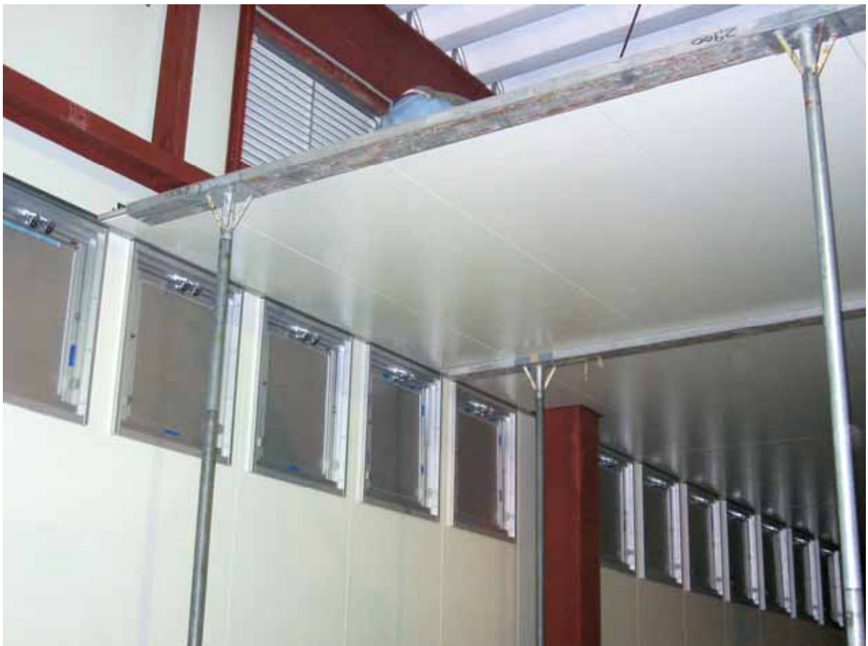
内部天井パネル 組立工事
