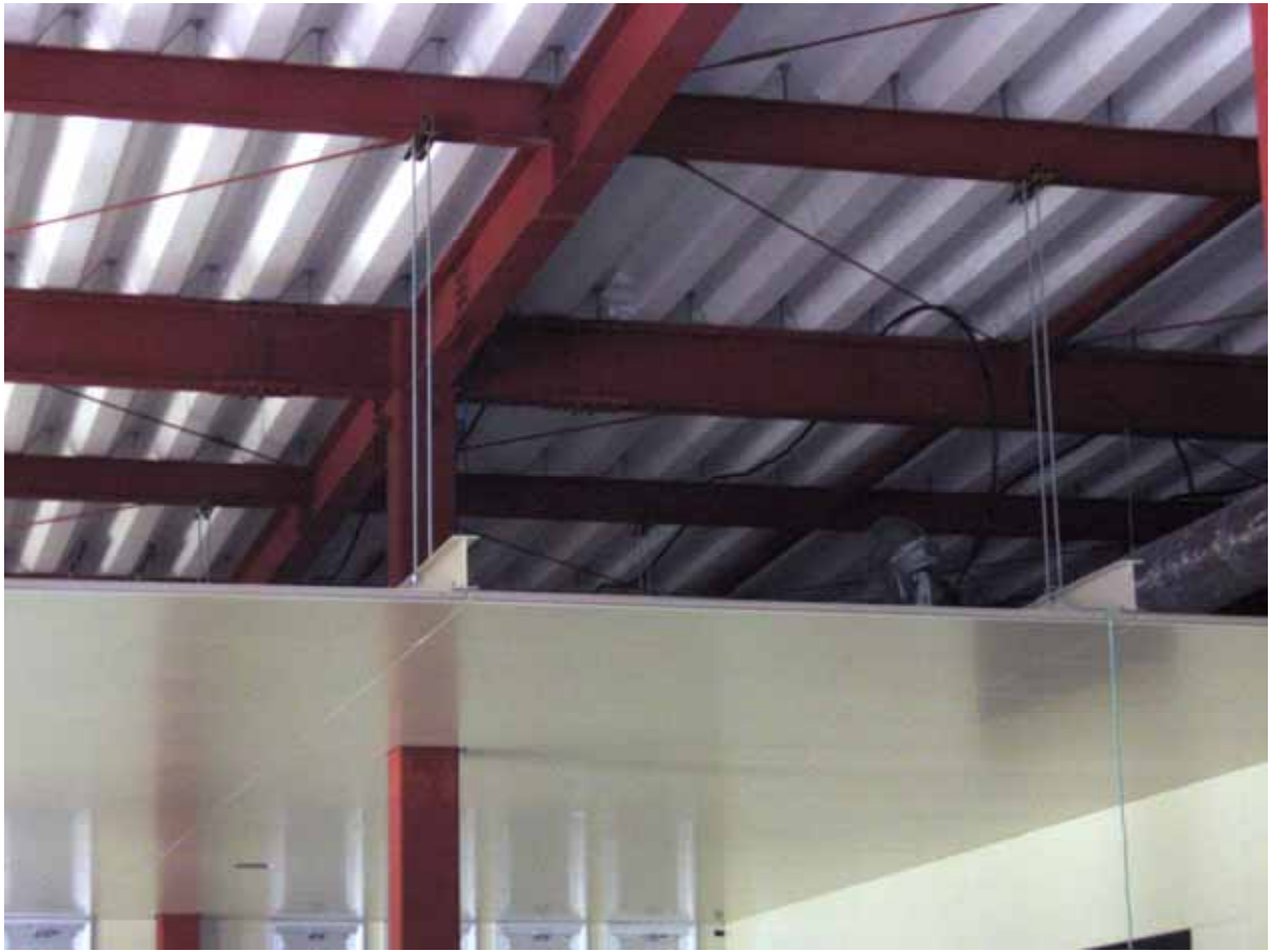
天井トラス吊り金具、天井部柱取合い
