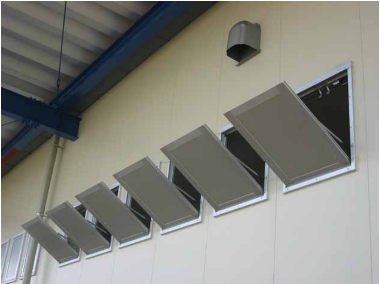
外壁パネル、排煙窓 開
