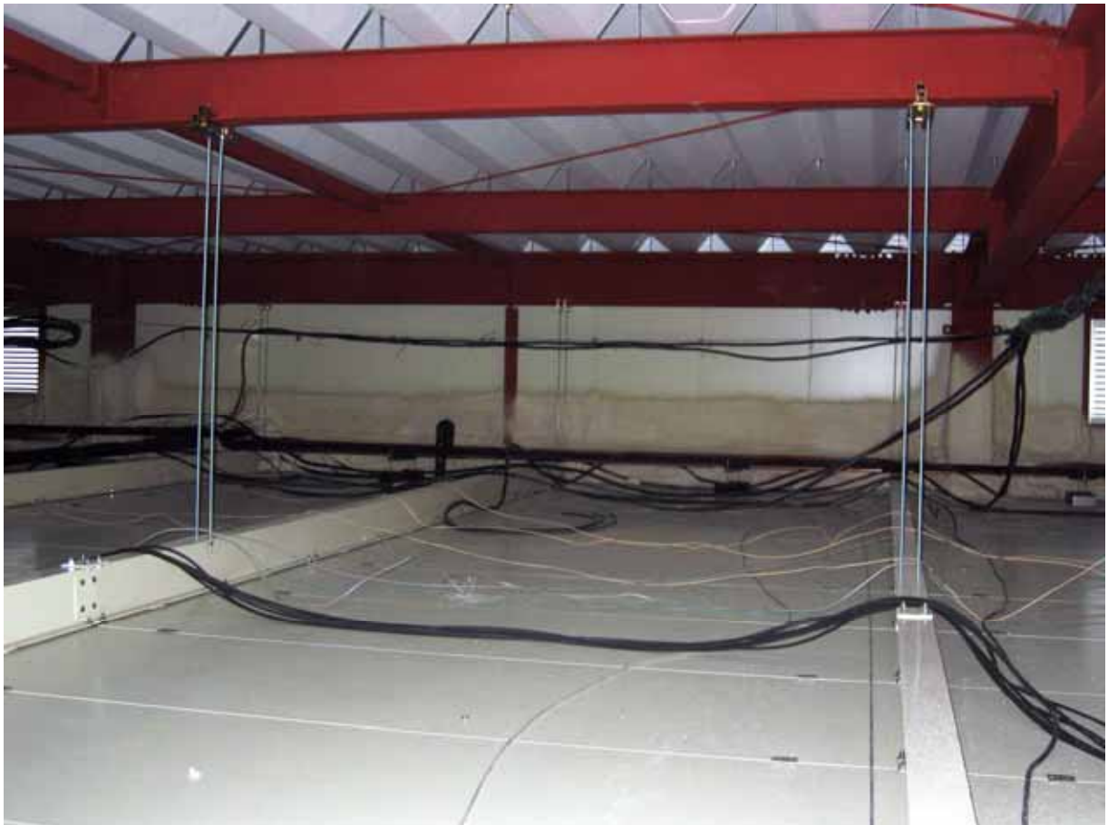
天井トラス吊り金具、天井パネル補強材
